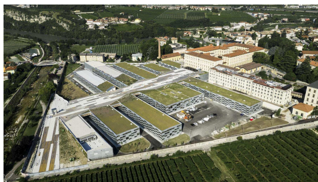
Veduta dall'alto dell'area del settembre 2020
