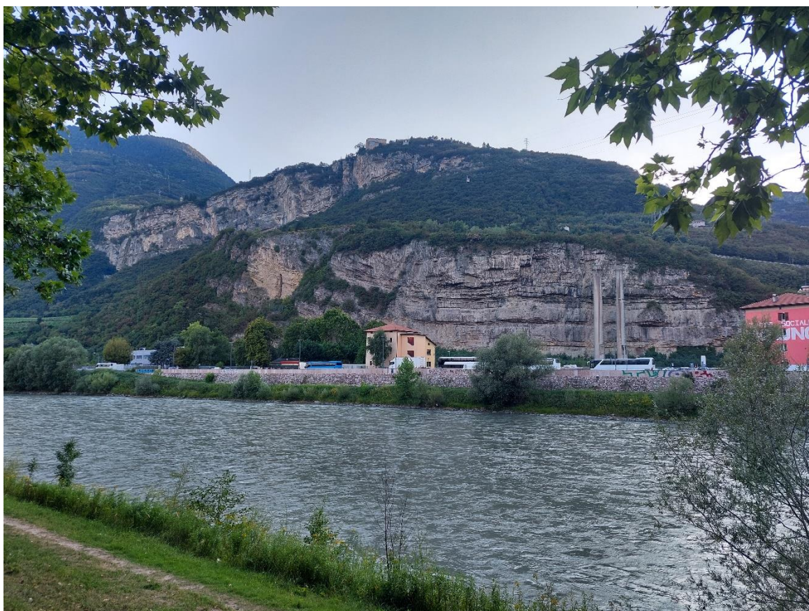
Figura 15: Vista area EX- Italcementi dove è previsto la prima stazione intermedia
