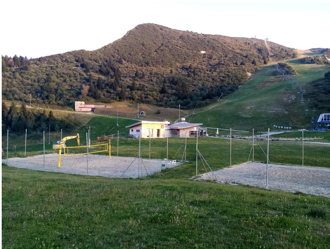
Figura 26: loc. Vason area dove è prevista la realizzazione della stazione di monte
