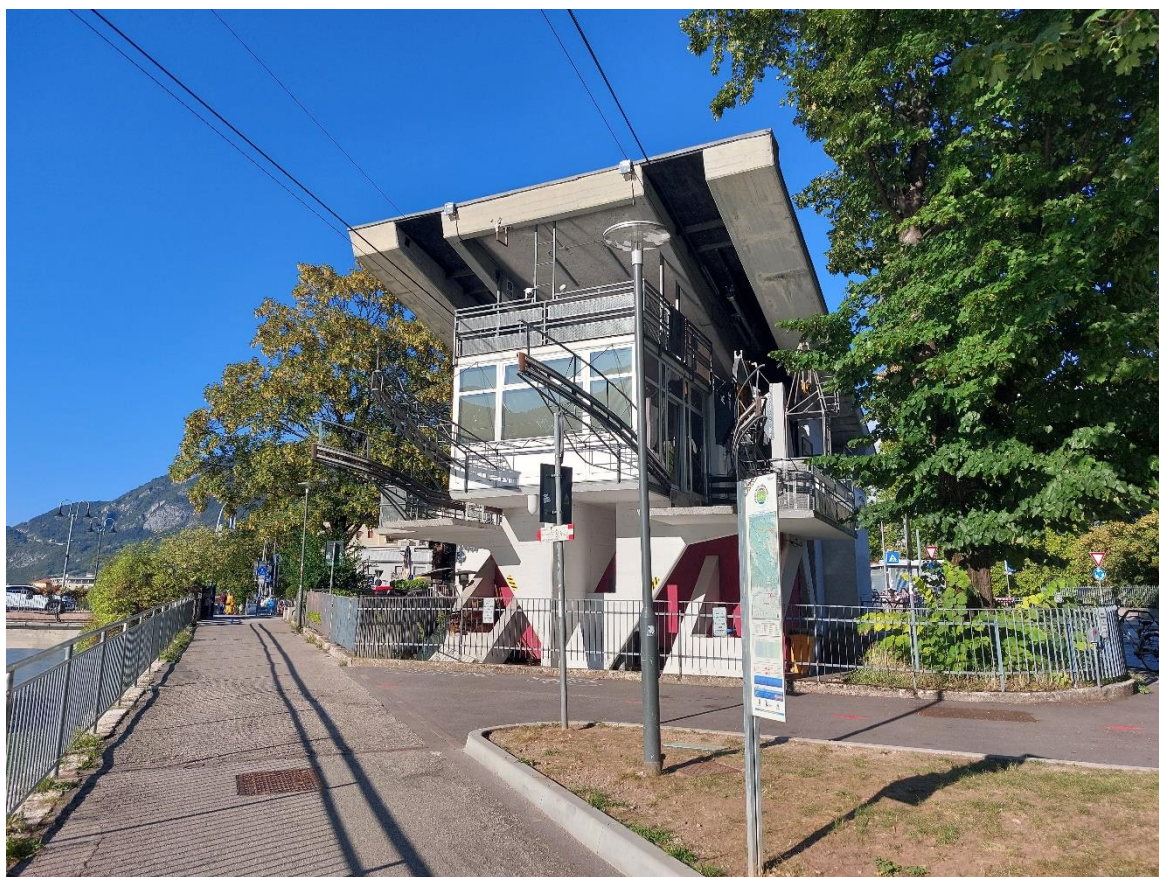
Figura 29: Stazione di valle attuale Funivia Trento - Sarnonno della quale è prevista la dismissione
