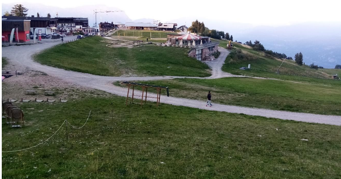
Figura 27: loc. Vason area dove è prevista la realizzazione della stazione di monte
