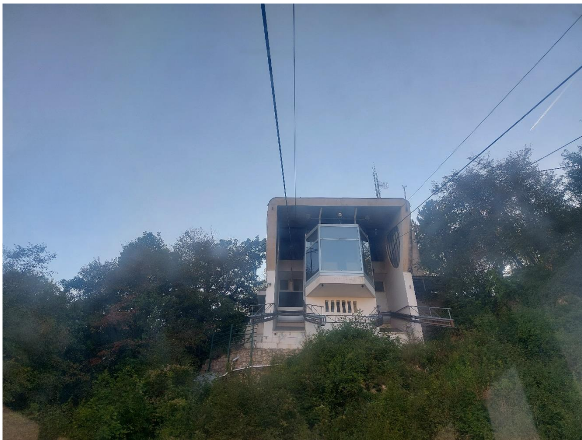
Figura 31: Stazione di monte attuale Funivia Trento - Sarnonno della quale è prevista la dismissione
