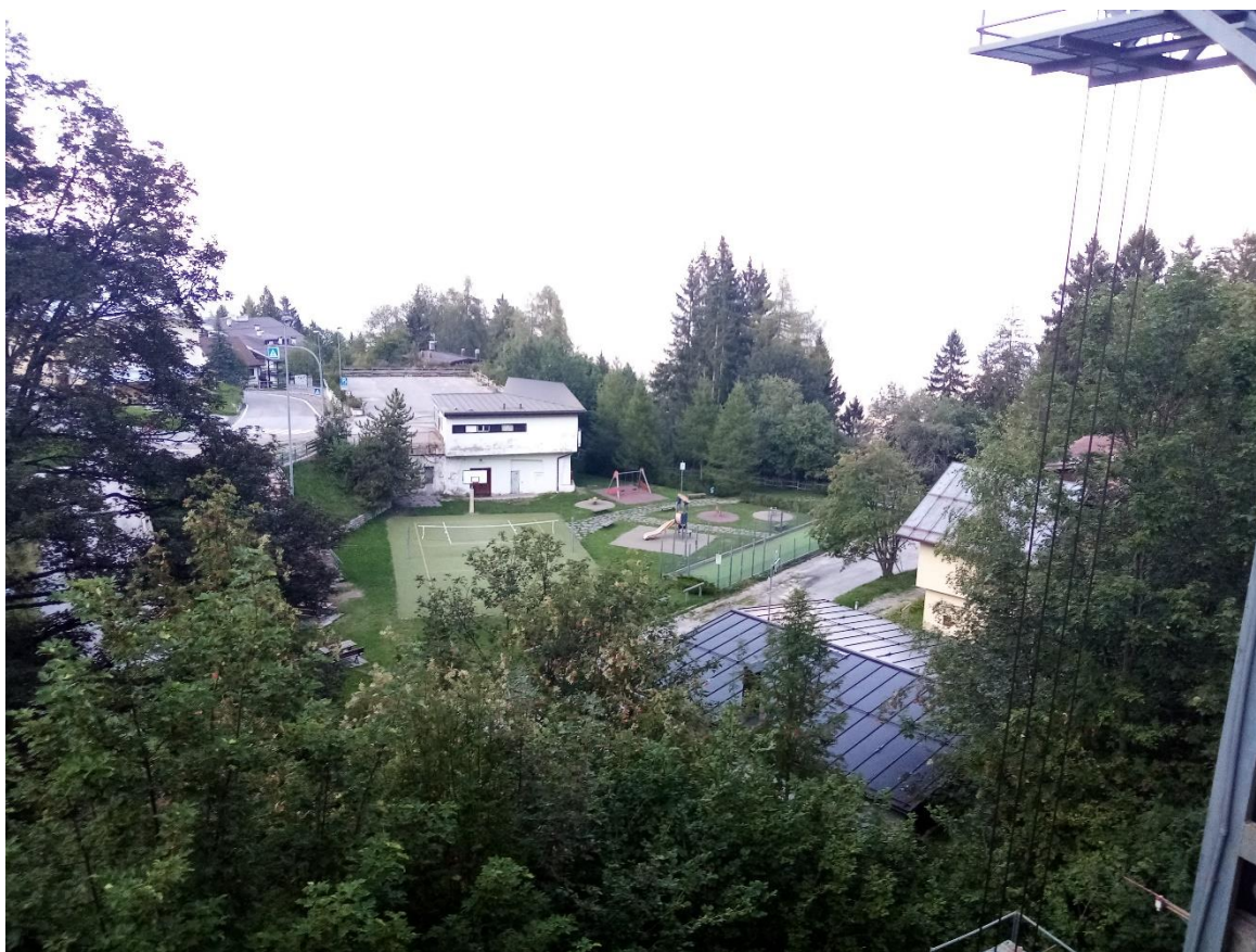
Figura 25: loc. Vaneze area dove è prevista la realizzazione della stazione intermedia
