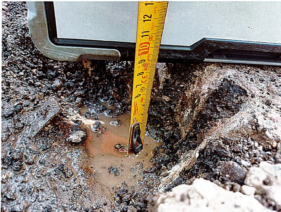
Foto 3 – spessore asfalto circa 9 cm – provino 2
