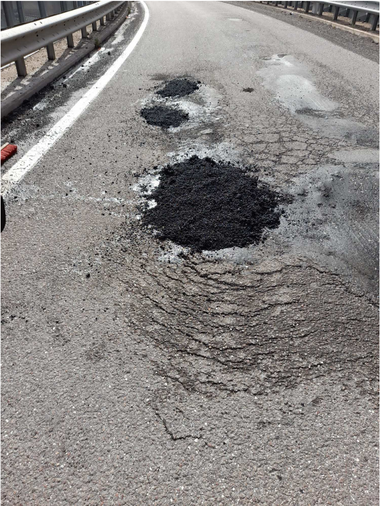
Foto n. 3 – Fasi di tamponatura temporanea delle buche con asfalto a freddo.
