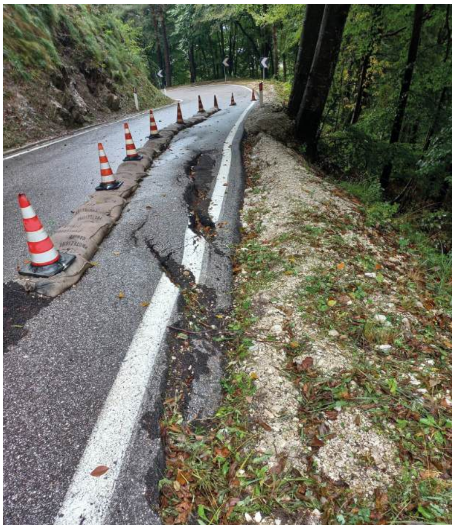
INTERVENTO 2 - SP 133 - Km 3+950 circa
