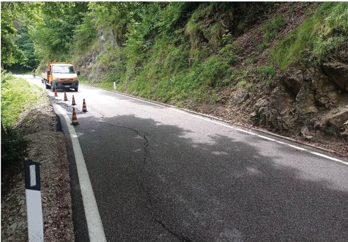
INTERVENTO 1 - SP 133 - Km 3+800 circa
