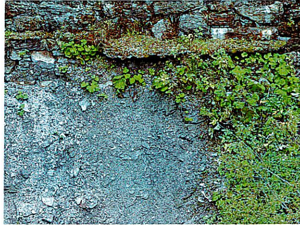
Foto 6 – Particolare area fondazione muro di sostegno SS50
