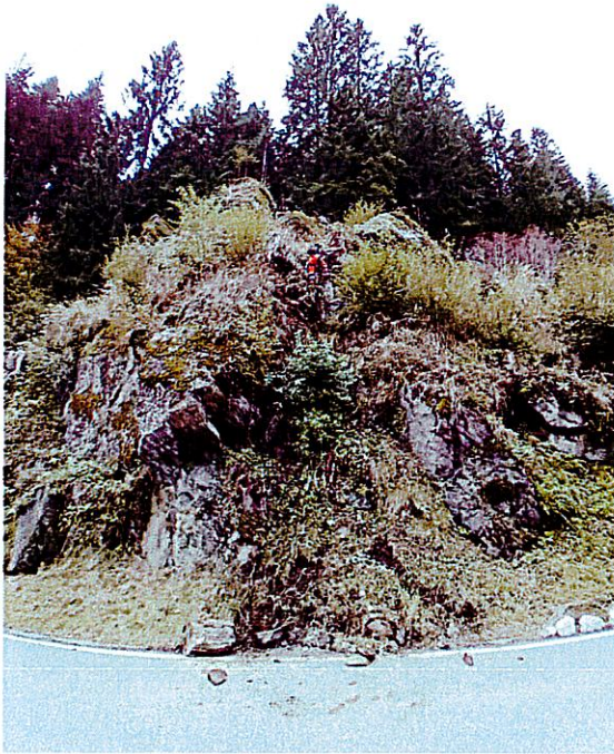
Foto 3- Vista generale area intervento 1 – macereto
