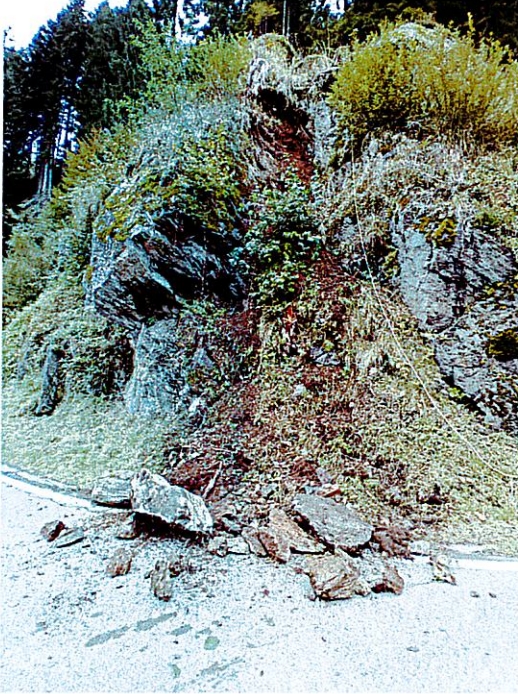
Foto 1- Immagine distacco ammassi rocciosi intervento 1
