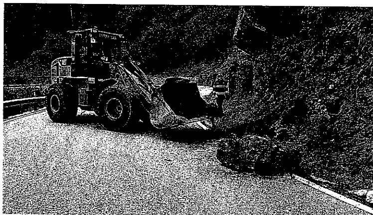
Foto 4- Immagine distacco ammassi rocciosi - particolare
