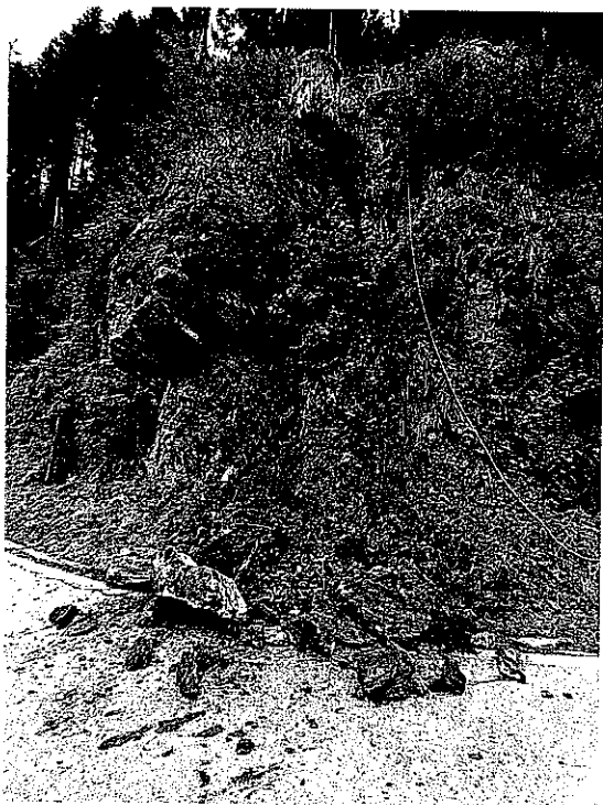
Foto 1- Immagine distacco ammassi rocciosi intervento 1
