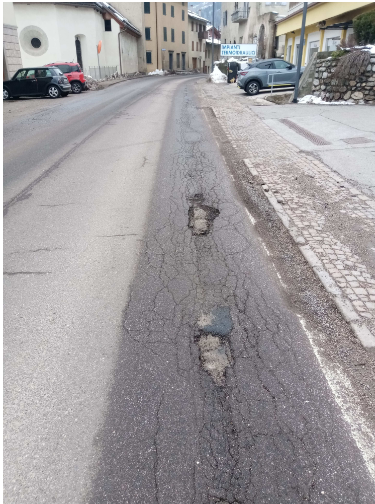
SS 42 km 163+990; ormaiamento esteso e collasso del corpo stradale in concomitanza degli eventi estremi del 01/04/2024
