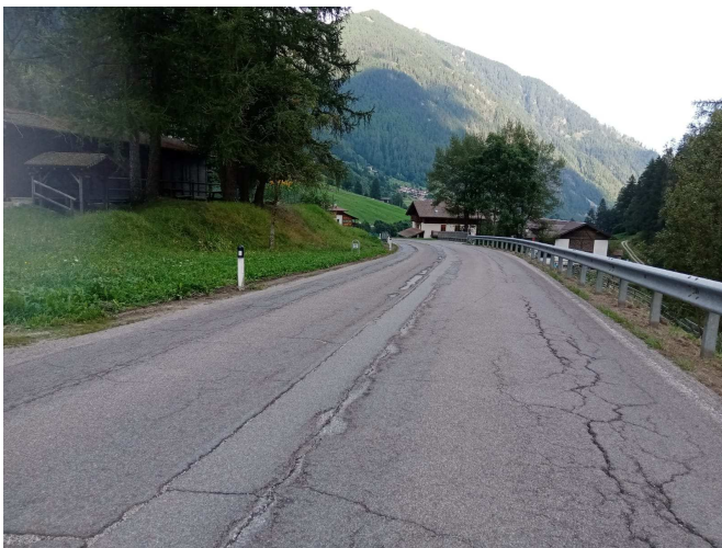
SP 86 di Rabbi dal km 7+800 al km 9 +300 circa; ammaloramenti diffusi, fessurazioni reticolari, buche profonde e cedimenti estesi con principio di collasso del intero corpo stradale
