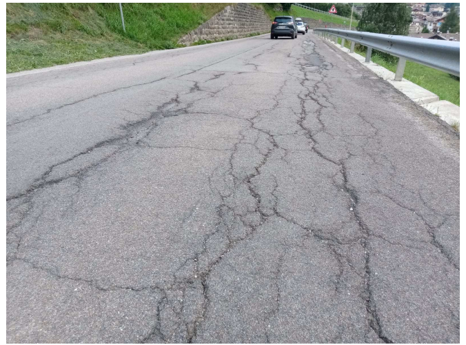
SP 86 di Rabbi dal km 7+800 al km 9 +300 circa; ammaloramenti diffusi, fessurazioni reticolari, buche profonde e cedimenti estesi con principio di collasso del intero corpo stradale
