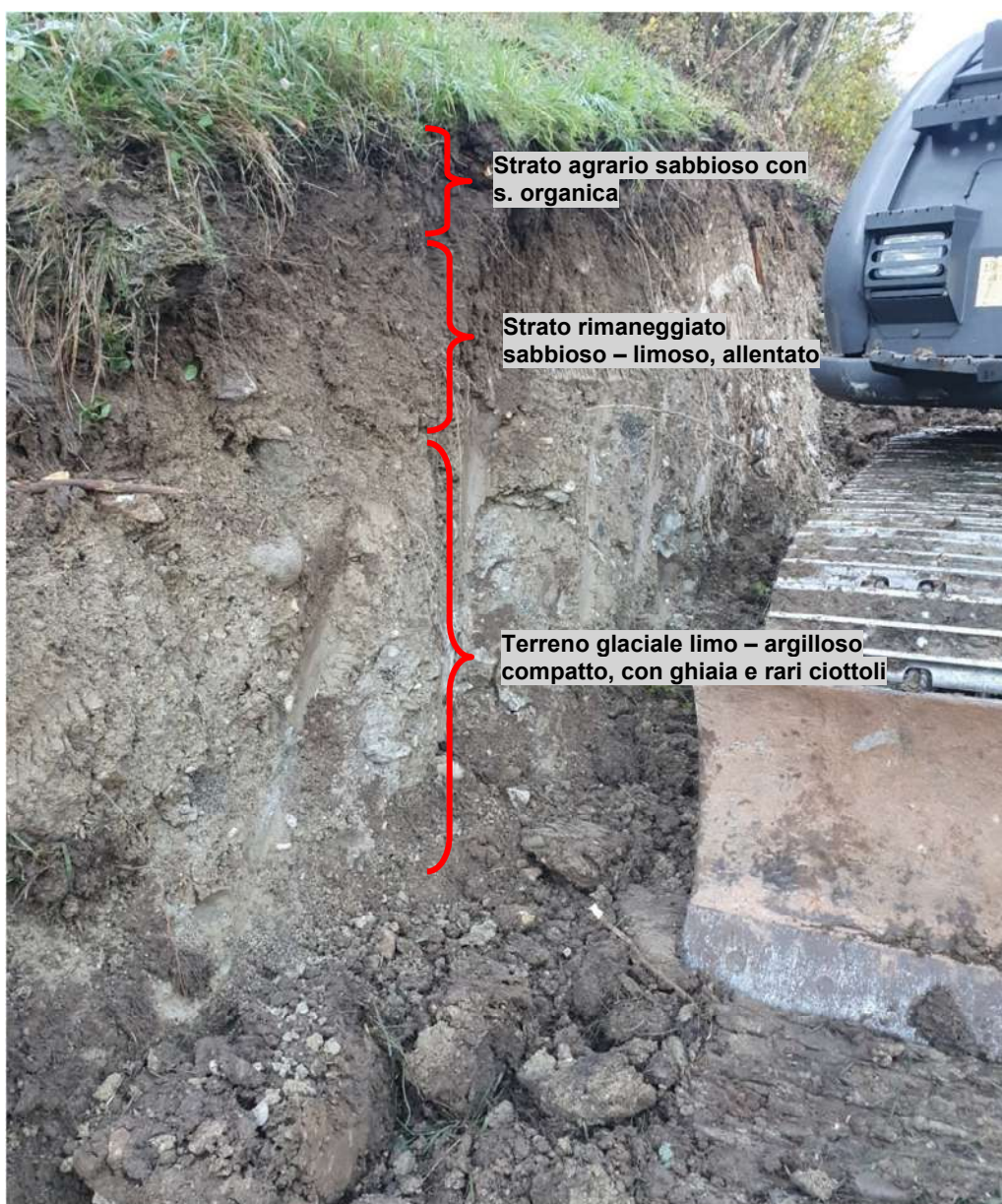
Foto 3: stratigrafia dello scavo nell'area dei lavori
