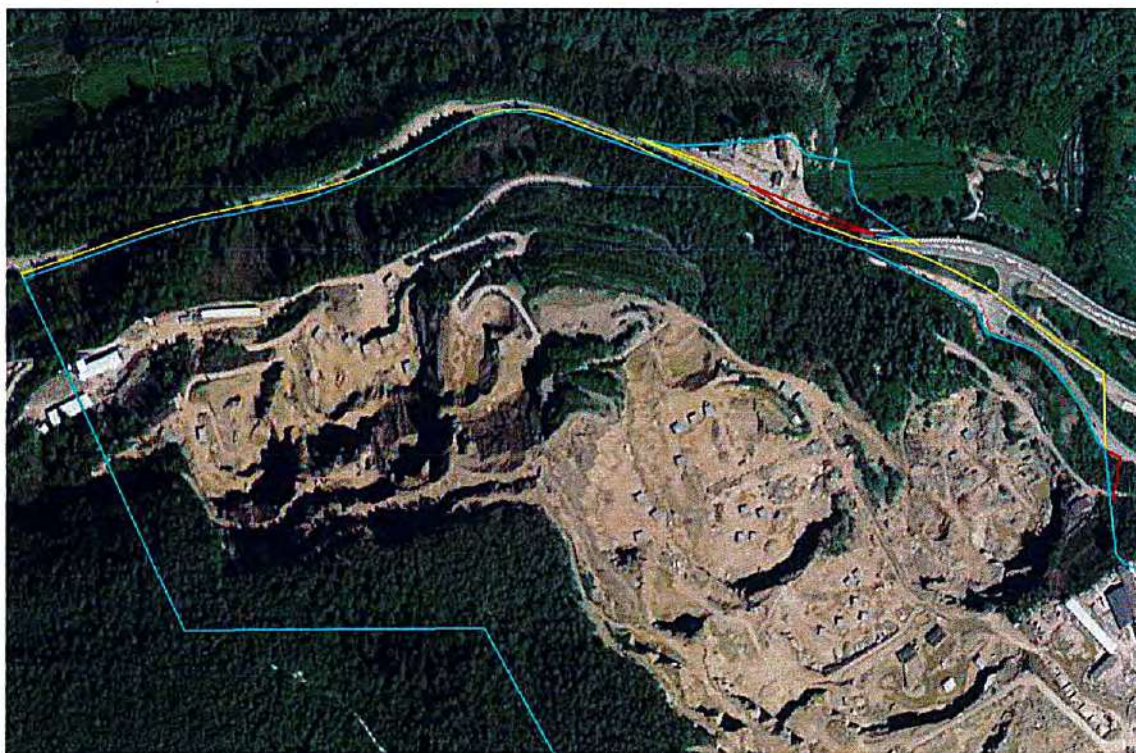
1.3 Particolare ingrandito foto aerea area estrattiva per porfido denominata "Montegaggio-Rio Secco"
