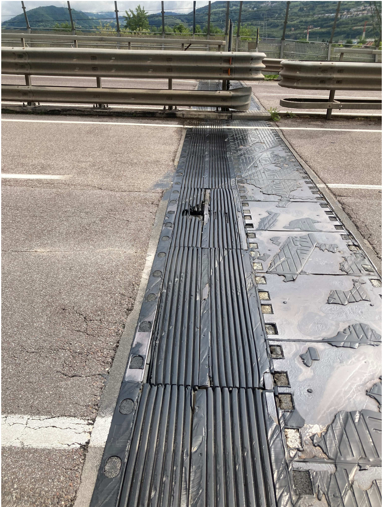
Foto n. 1 – Il giunto sud del viadotto “Avisio” alla progr. km 4,115 – Carreggiata sud.
