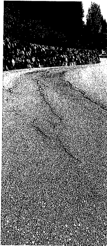
Foto n.12 - gradino più che centimetrico/curva disassata
