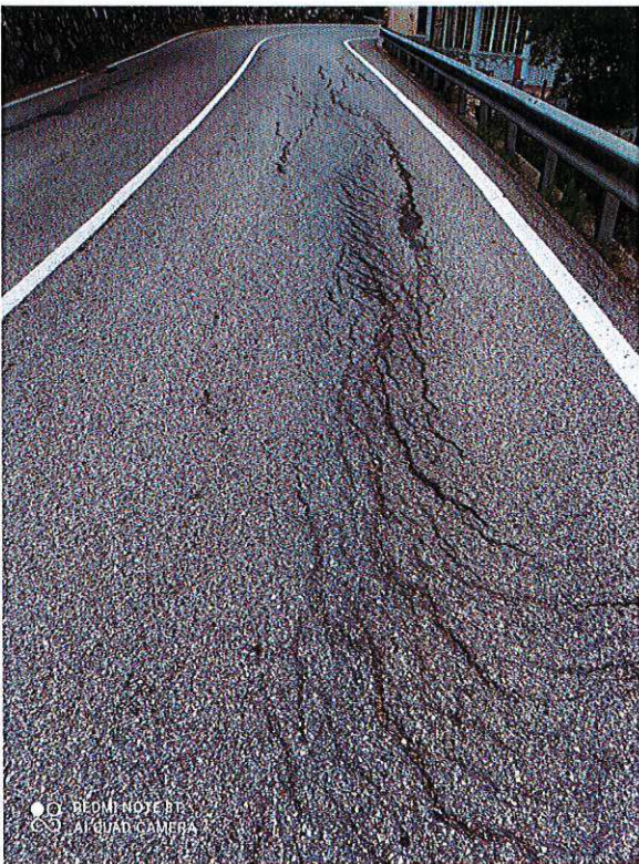
Foto n. 5 -ondulazioni/pieghe profonde
