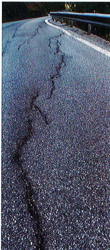
Foto n. 8 -gradino più che centimetrico
