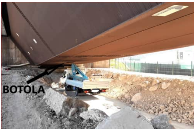
Zona di accesso alla botola per i materiali
