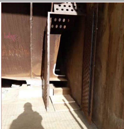
Accesso di servizio di valle visto dall'esterno
