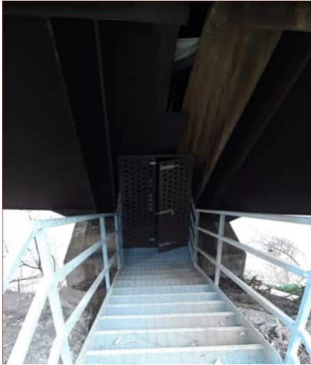
Scala di accesso al vano ispezione
