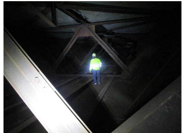
Interno vano ispezione e relative travature
