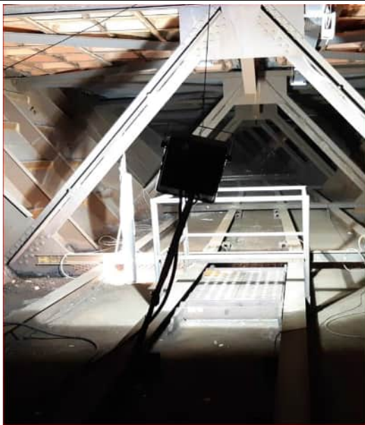
Botola vista dall'interno del vano chiusa
