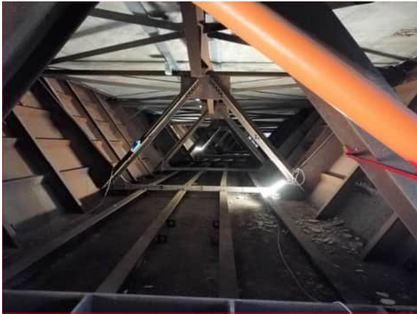
Interno vano ispezione e relative travature
