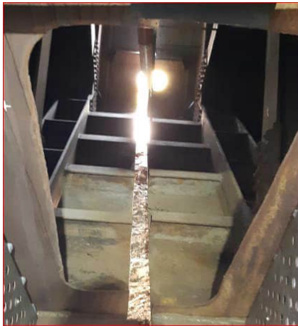
Interno vano ispezione - zona di collegamento delle campate con fessure di assorbimento delle dilatazioni
