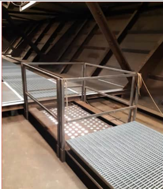
Botola vista dall'interno del vano chiusa
