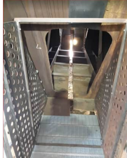
Porta di ingresso vano ispezione
