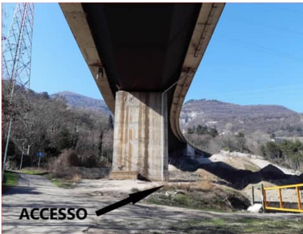
Accesso al punto di fornitura energia elettrica
