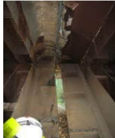
Interno vano ispezione - zona di collegamento delle campate con fessure di assorbimento delle dilatazioni
