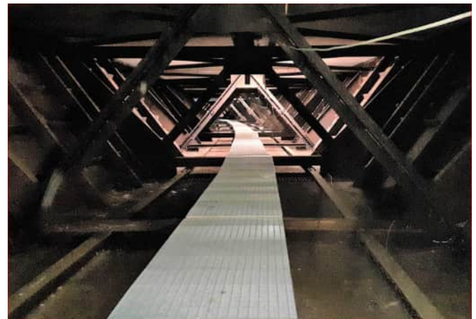
Interno vano ispezione tratto attrezzato con passerella con evidenziato il gradino sui bordi della stessa
