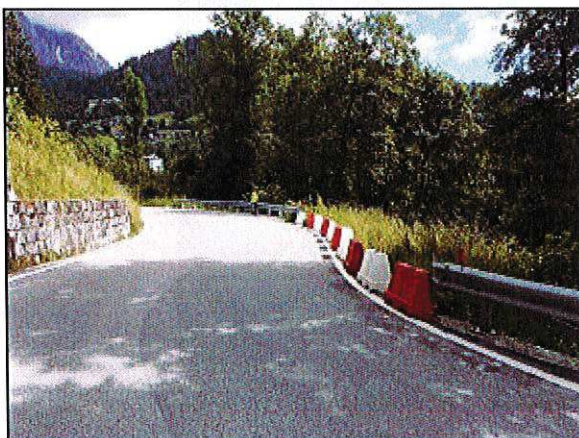
FOT.3 - Installazione barriere new jersey fronte strada
