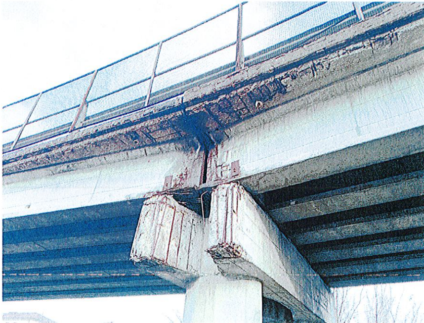
Foto 3 – vista dell'avanzato stato di deterioramento in corrispondenza del pulvino
