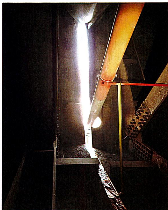
Interno del cassone con evidenziate le feritoie in corrispondenza dei giunti
