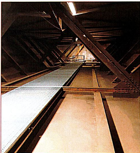
Viste interno cassone con passerella, gradino sui bordi della stessa e travature fonti di ostacolo
