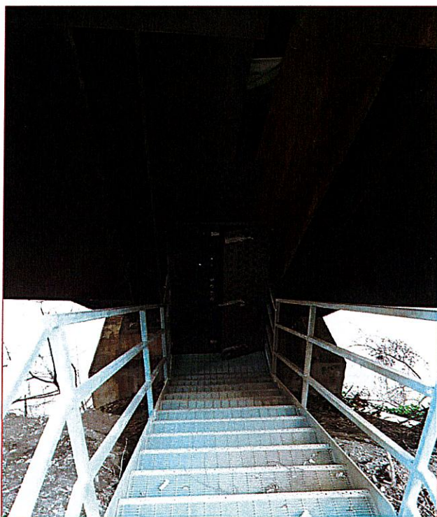
Scala di accesso al cassone
