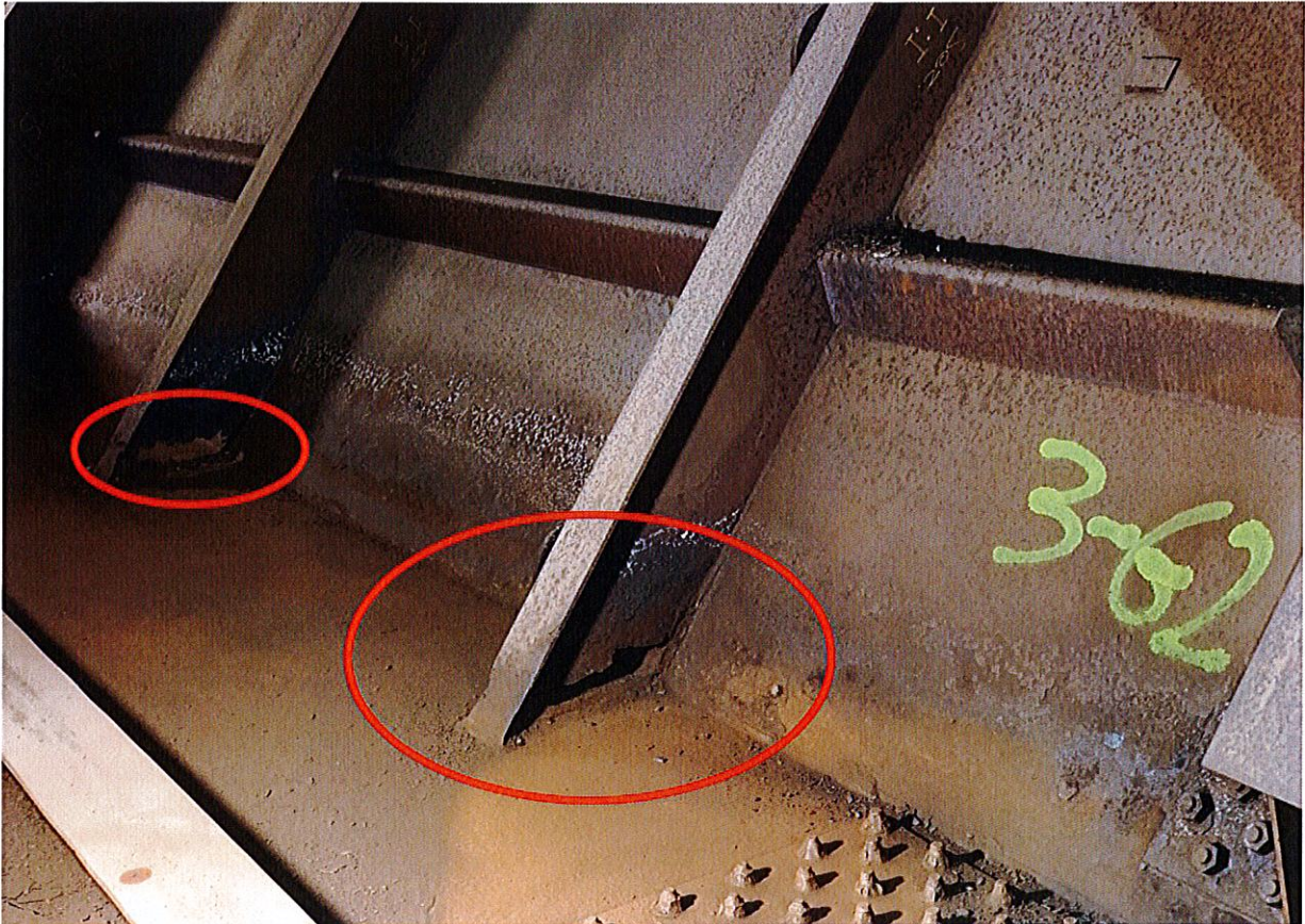
Foto 7 – ammaloramenti con perdita totale di sezione delle costolature laterali, campata 3, in prossimità del giunto G2
