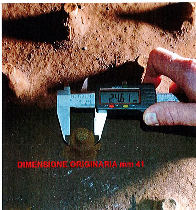
Foto 13 – misurazione a campione del dado. Dagli originari 42 mm (dado maggiorato M24 come da progetto) si rilevano oggi 24,61 mm di spessore, con evidente perdita di sezione.
