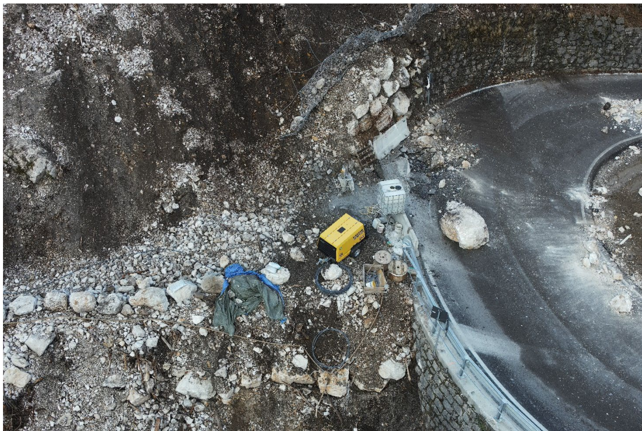
Immagine n. 6 – Materiale franato in corrispondenza del tornante (data presa 12.02.2024)
