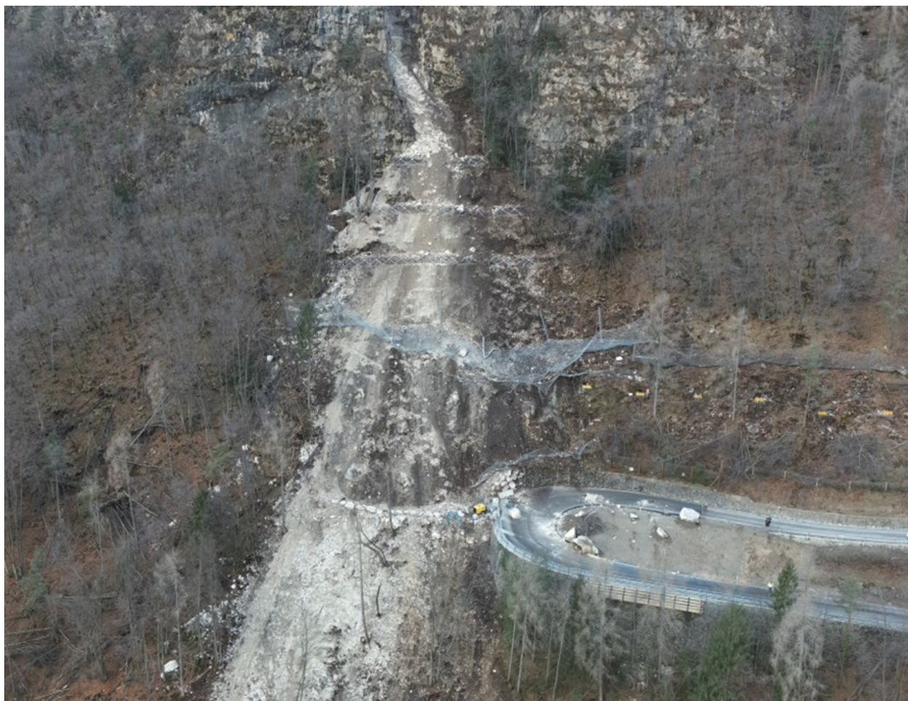
Immagine n. 1 – Vista generale fronte franoso (data presa 12.02.2024)
