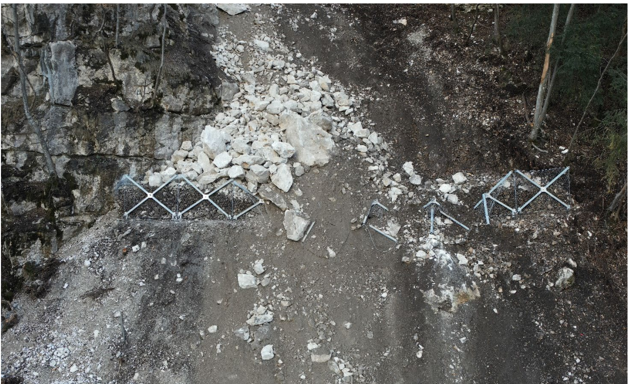
Immagine n. 5 – Ombrelli monoancoraggio (data presa 12.02.2024)
