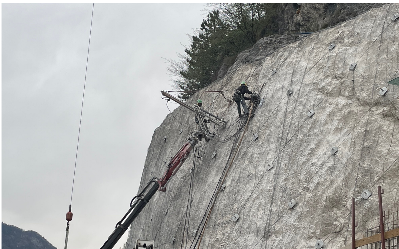
FOTO n. 3 – Operazioni di chiodatura parete
