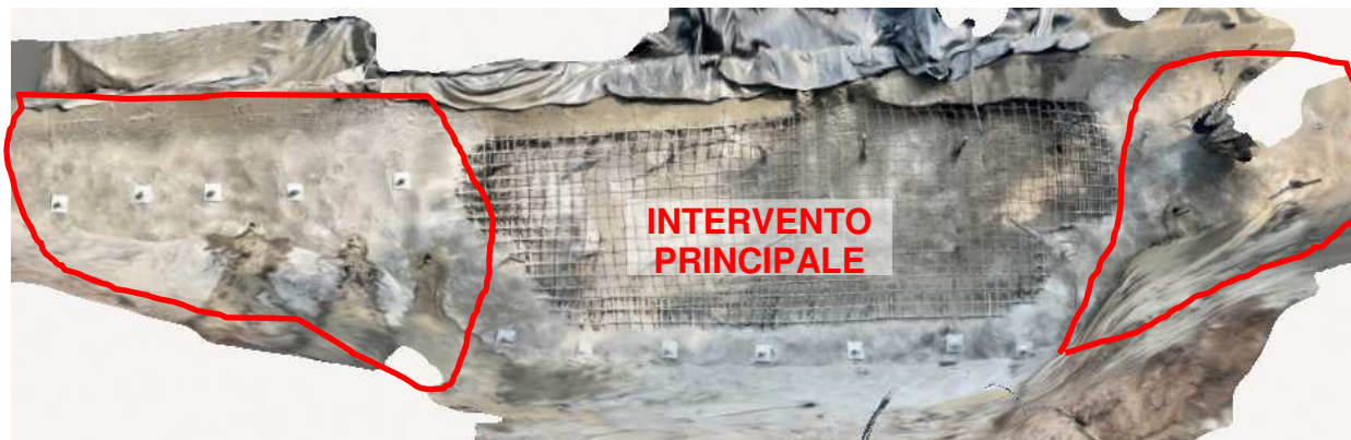
Fig. 13: soil nailing realizzato lateralmente alla zona di intervento principale
