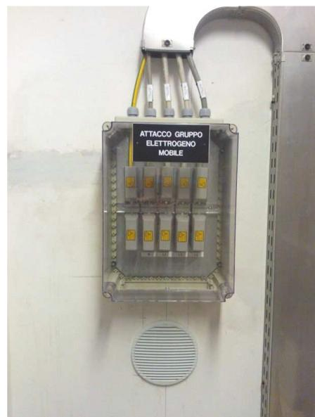
*1) esempio di morsetti nel quadretto per il gruppo elettrogeno mobile all'interno*
