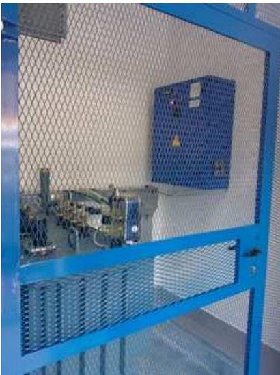
*Quadro di rifasamento fisso del trafo all'interno del box di protezione*
