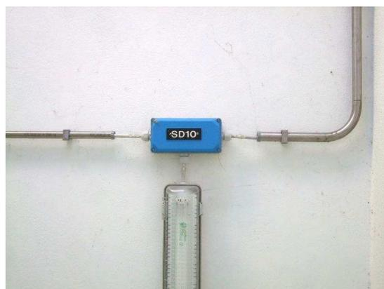
*impianto luce a soffitto (guida cavo al di sopra dei 2,5m)*
