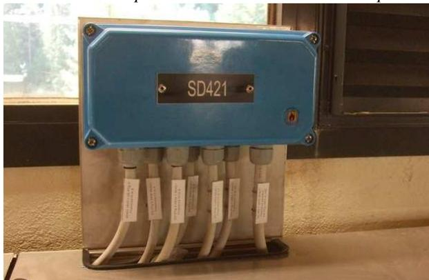
passaggio cavi con guarnizione di protezione
