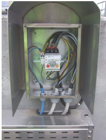
*Interruttore sezionatore con sola protezione magnetica (da completare)*
