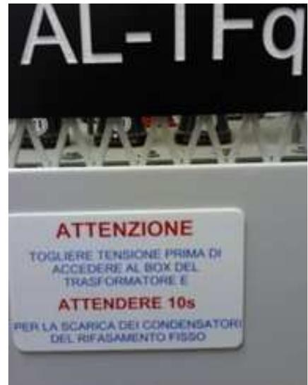
*Targa indicante il tempo di scarica del Condensatore posta sulla rete della gabbia*
