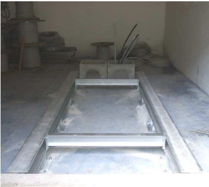
*telaio di supporto / rialzo del Gruppo Elettrogeno al livello della soglia di ingresso – i due pozzetti, opportunamente rivestiti, separano la vasca di contenimento dal resto dell'impiantistica*
