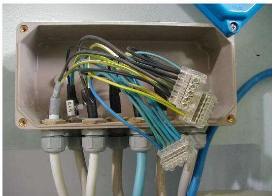
*esempio di morsetti multipli da utilizzare per le derivazioni nei circuiti luce e prese (lavorazione incompleta)*
