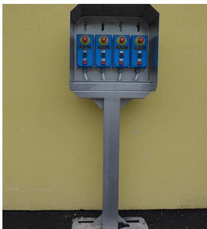
*Soluzione per PCL multiple all’aperto. Con la canala cavi in acciaio inox che serve anche da sostegno alla struttura*
