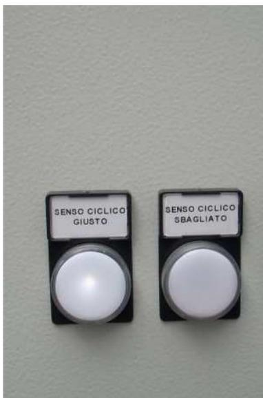
*lampade spia per il controllo del corretto collegamento delle fasi mediante il fasometro*
