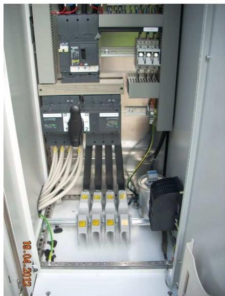
*2) in basso i morsetti posati all'interno del quadro per il collegamento del GE*
