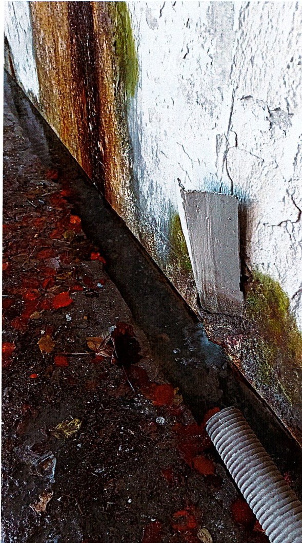
Foto n. 3 – apporto di acque dalla volta nella galleria Limarò.
