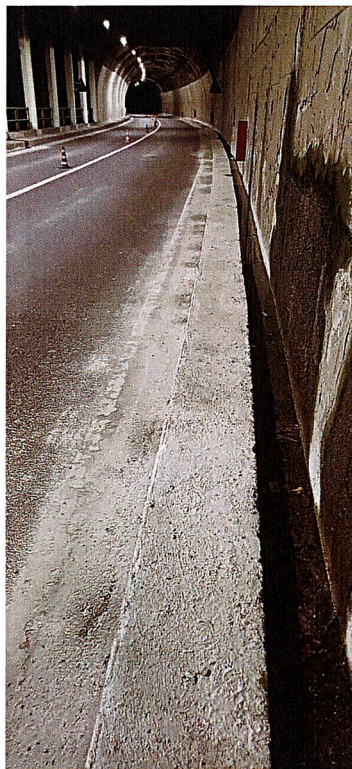
Foto n. 9 – realizzazione di nuovi tratti di canalette sulle banchine soprelevate in cls.
