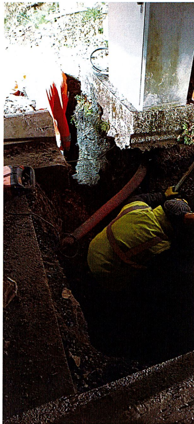
Foto n. 8 – realizzazione di due pozzetti con attraversamento stradale e relativo scarico all'altezza dell'ingresso della galleria Limarò (pr. km. 105,064 - ingresso galleria Limarò misurato dalla pr. km. 105,000).
