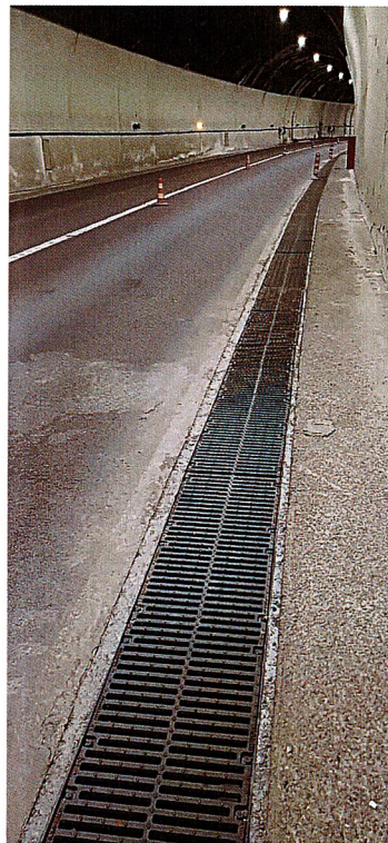
Foto n. 7 – posa nuove griglie nella galleria Limarò.
