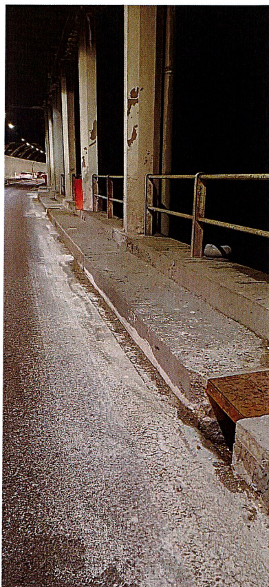
Foto n. 10 – ripristino degli scarichi in sinistra all'altezza dei finestroni della galleria Limarò.
