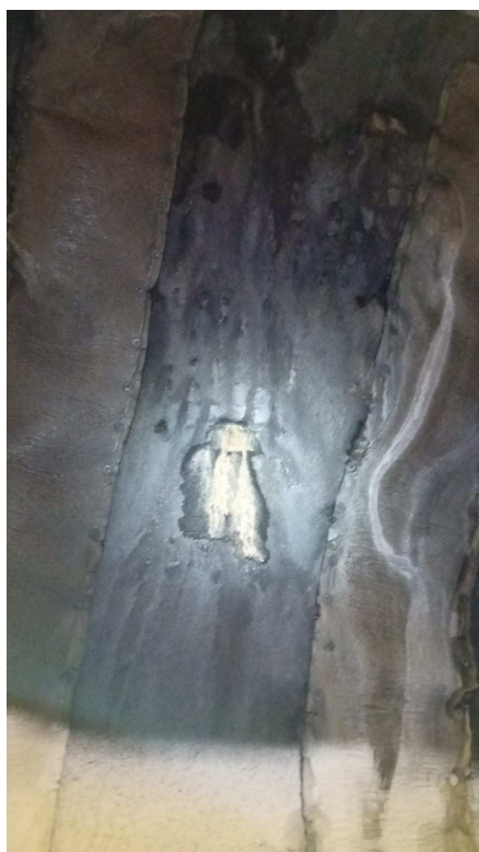
Foto n. 1-2 – nuovi apporti di acqua dalla volta della galleria Ponte Pià, a fianco di centine esistenti
