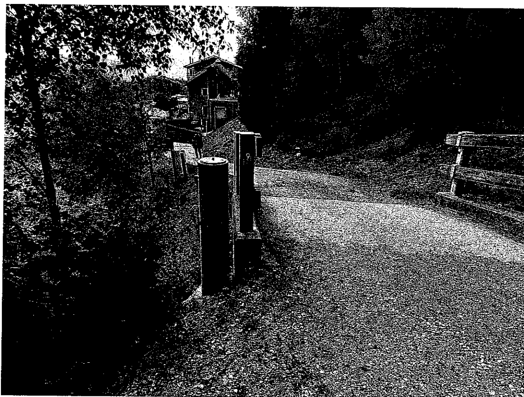
Pilastrino P11 posizionato lungo la strada forestale che conduce alla loc. Pian di Casara
