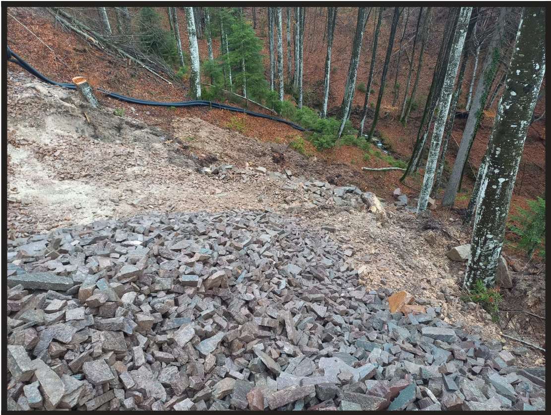
KM 20+200 riprofilatura scarpata a valle
