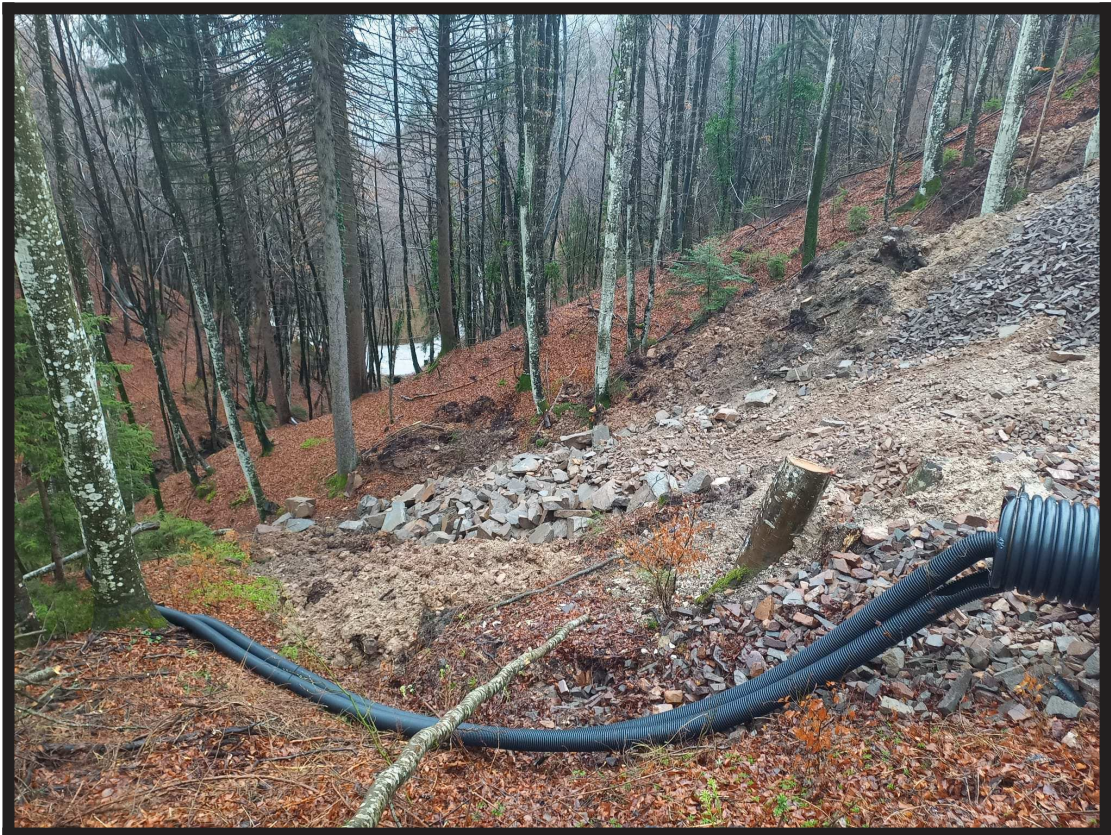
KM 20+200 prolungamento del tubo con canaletta
