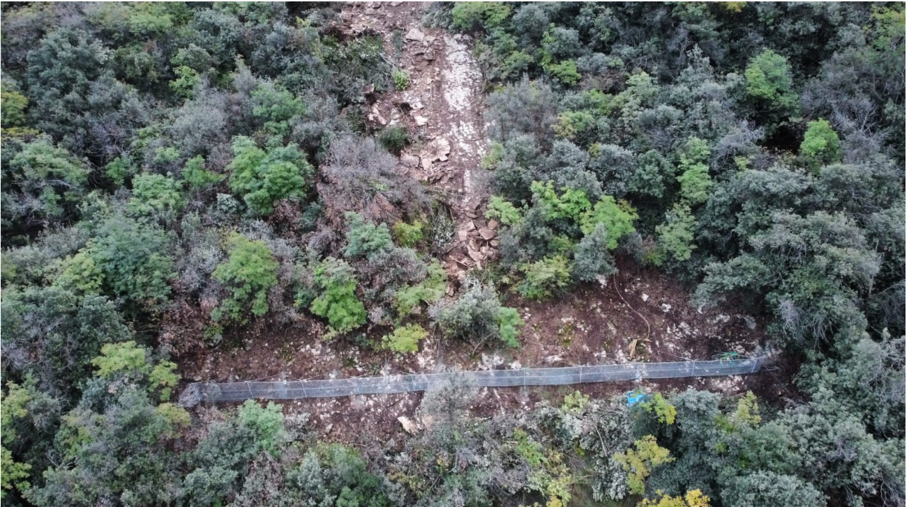
Foto n. 3 – Vista della frattura di distacco.
