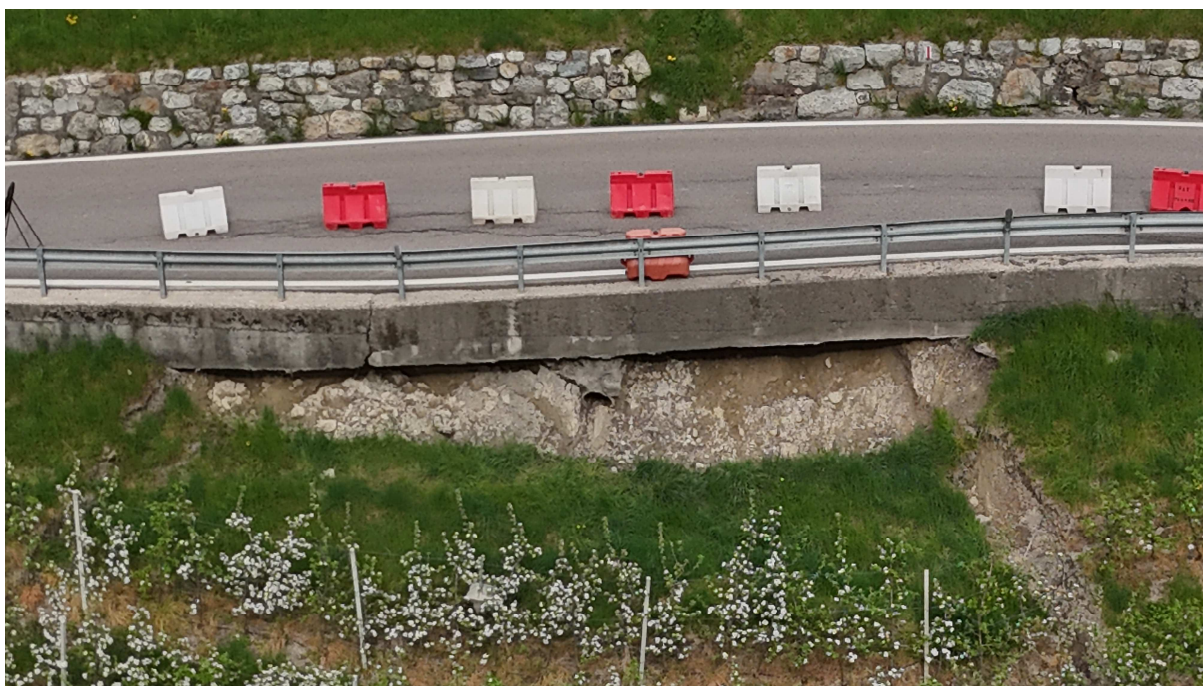
Foto 5: Area di intervento
