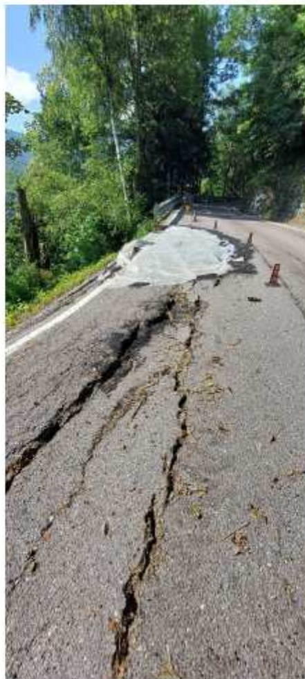
Le ampie fessure nella pavimentazione stradale
