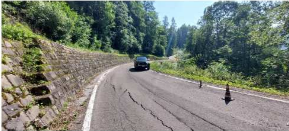
Le ampie fessure nella pavimentazione stradale
