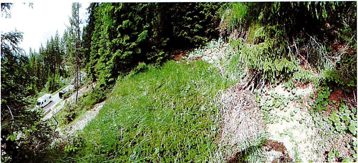
Area di testa con la fessurazione di oltre il ciglio aperta e beante. Si dovrà procedere anche con un taglio piante per alleggerire il ciglio risagomato.
