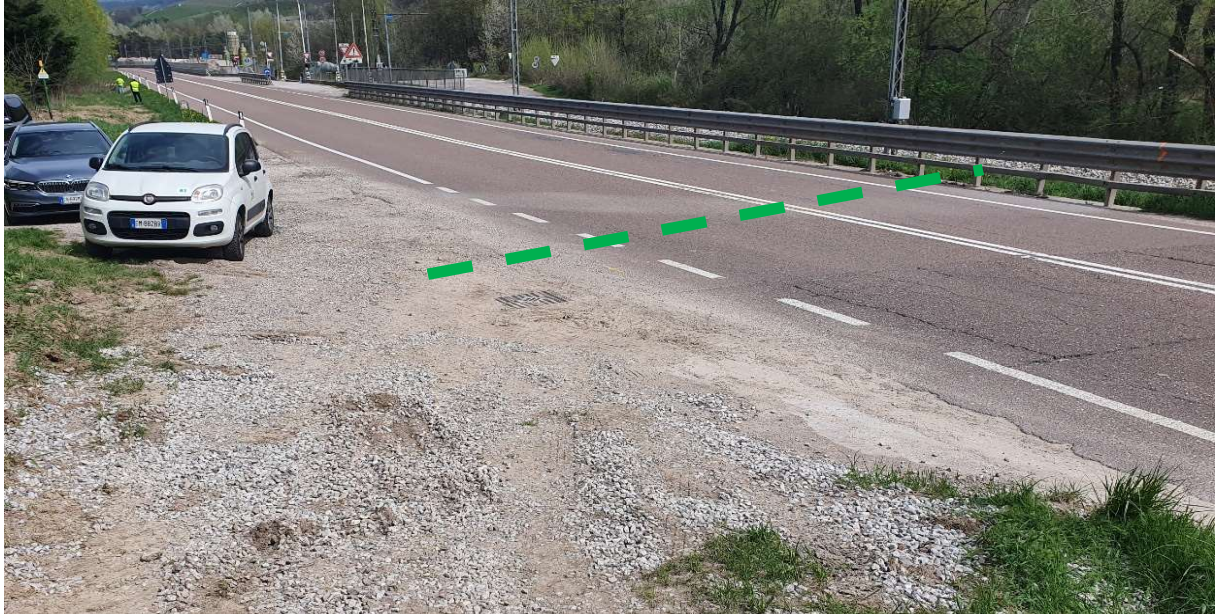
Figura 13: nuovo attraversamento da realizzare nella sede della S.S. 43 alla pr. Km 21+220 circa.
