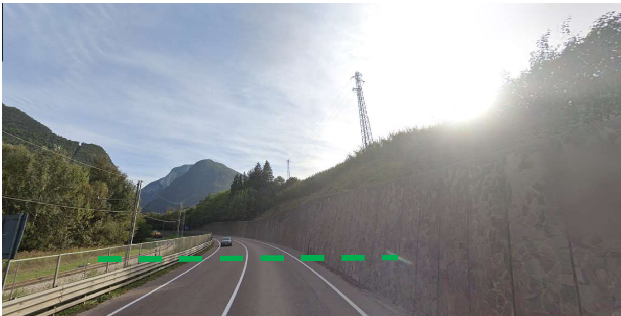
Figura 5: attraversamento esistente alla pr. Km 21+320 circa da ripristinare tramite nuove tubazioni
