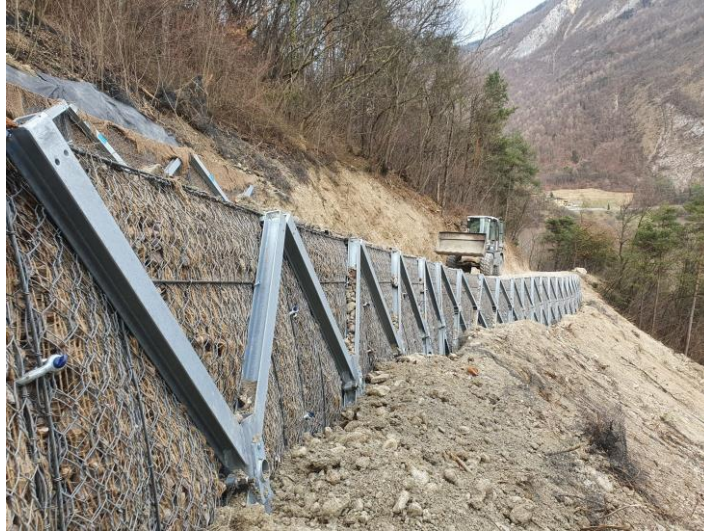
Esempio di impiego su un versante in frana
