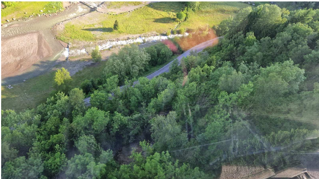
Vista aerea del km 0,400
