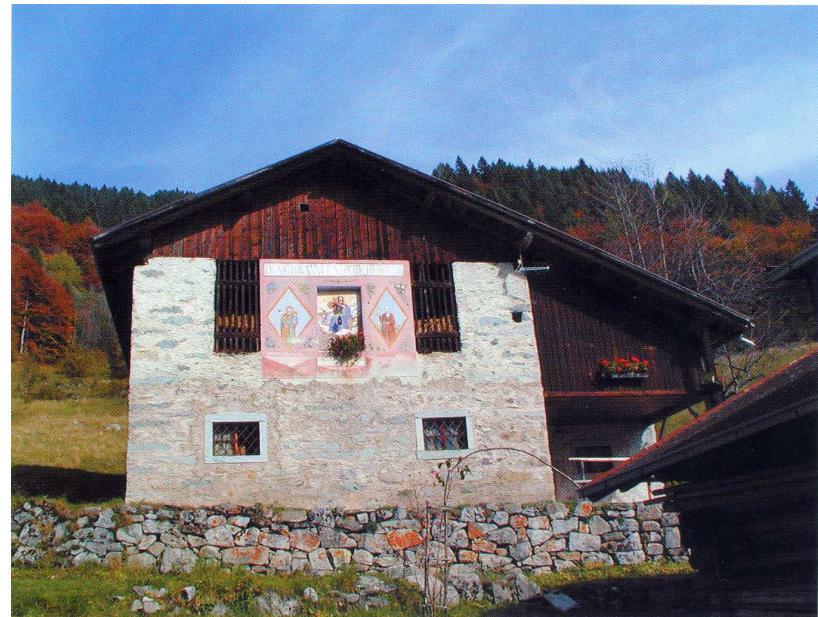
Elementi architettonici di rilievo in edifici montani tradizionali.
