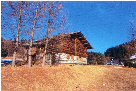
.Fori esiatenti e nuovi nelle pareti in muratura.
