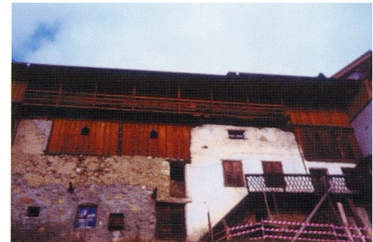
Facciate di maso recuperate secondo la tradizione. Intonacatura a civile anziché a raso sasso.
