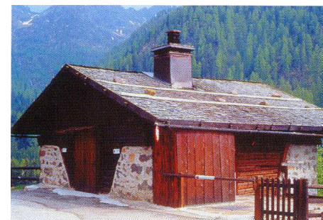
Tetto rifatto in scandole come in origine.
