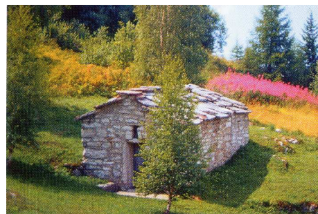
Tetto tradizionale in lastre di pietra.
