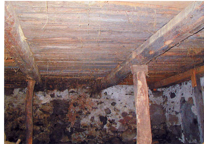
Strutture interne di edifici montani in pietra e legno
