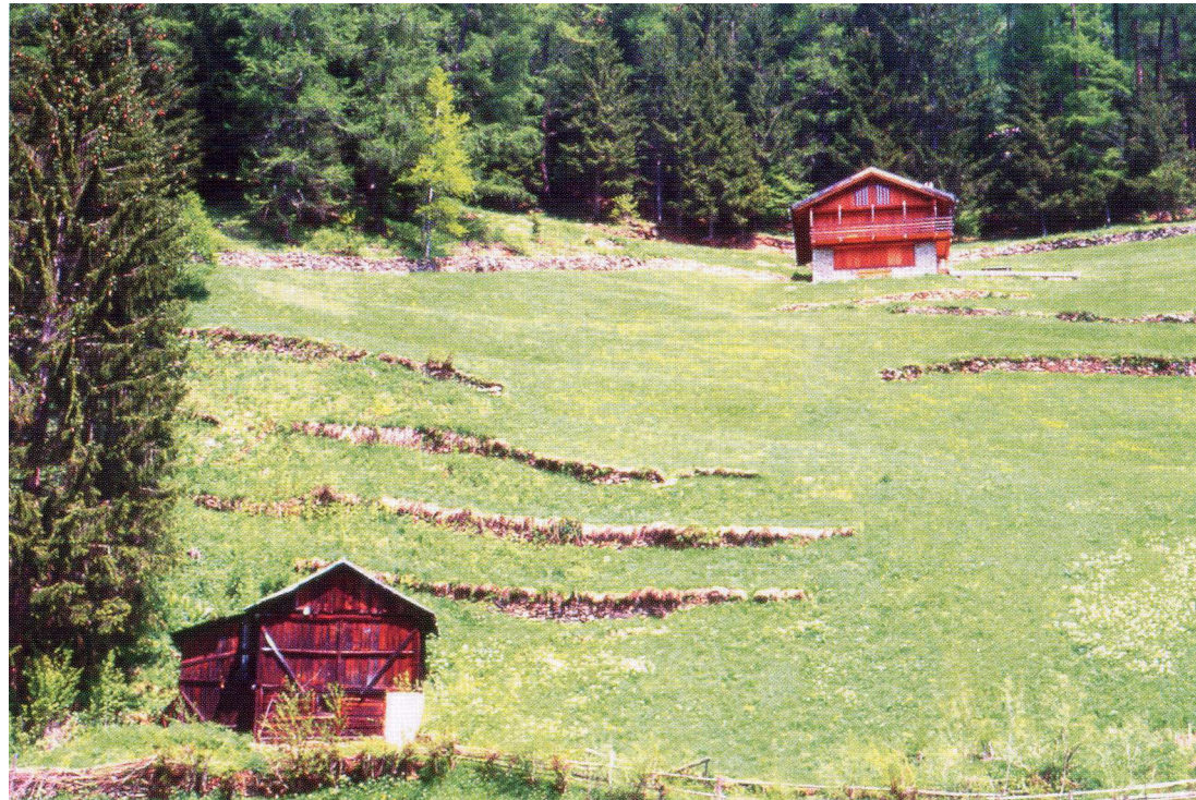
Maso tradizionale e maso ristrutturato con mantenimento del volume originario.
