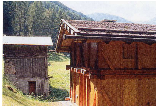
Facciate di maso recuperate secondo la tradizione. Intonacatura a civile anziché a raso sasso.
