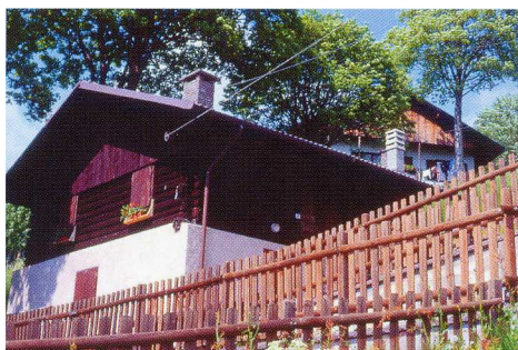
Recinzione estranea alla tradizione
