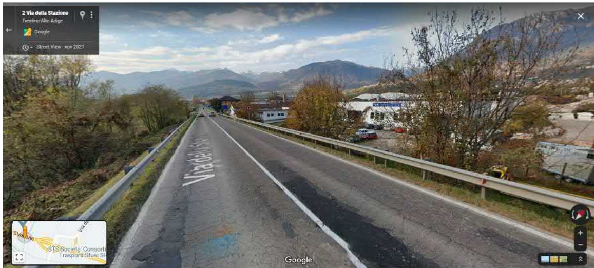
Figura 8 – Totale assenza di banchine su entrambi i margini esterni
