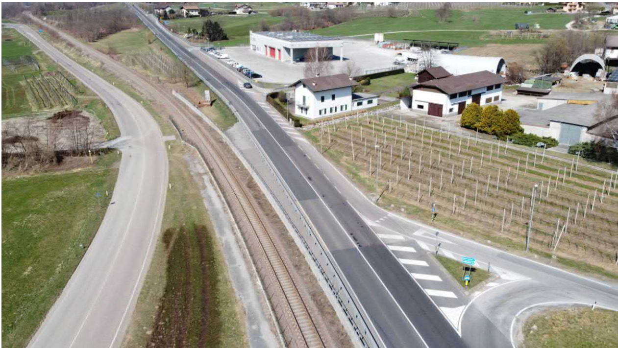
Figura 11 – Due esempi di accessi e intersezioni a distanza ridotta
