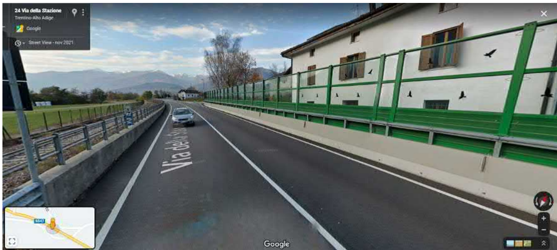
Figura 17 – Banchina esterna alla corsia ovest con larghezza inferiore a 0.50m (progr. 90+100 – 90+150)
