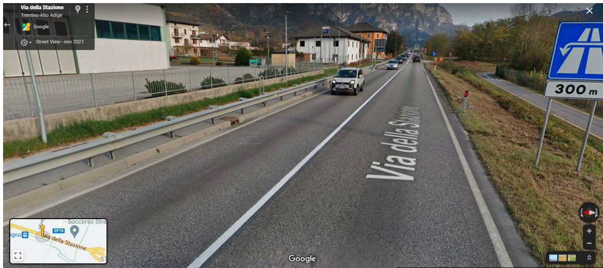
Figura 4 – Banchina assente in adiacenza al marciapiede e banchina di larghezza estremamente ridotta in destra
