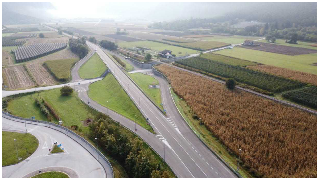
Figura 29 - Svincolo di Barricata
