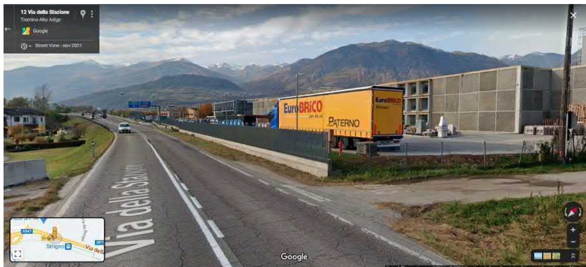
Figura 5 - Va adeguato il margine esterno per inserimento barriera per protezione da urto contro testata muretto di recinzione
