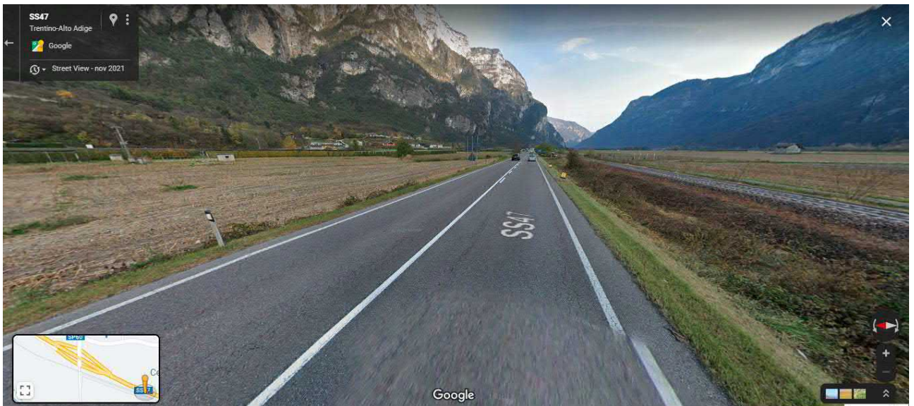
Figura 21 – Adeguare larghezza del margine esterno per installare barriere sul margine lato ferrovia. Verificare se sufficiente sul lato nord
