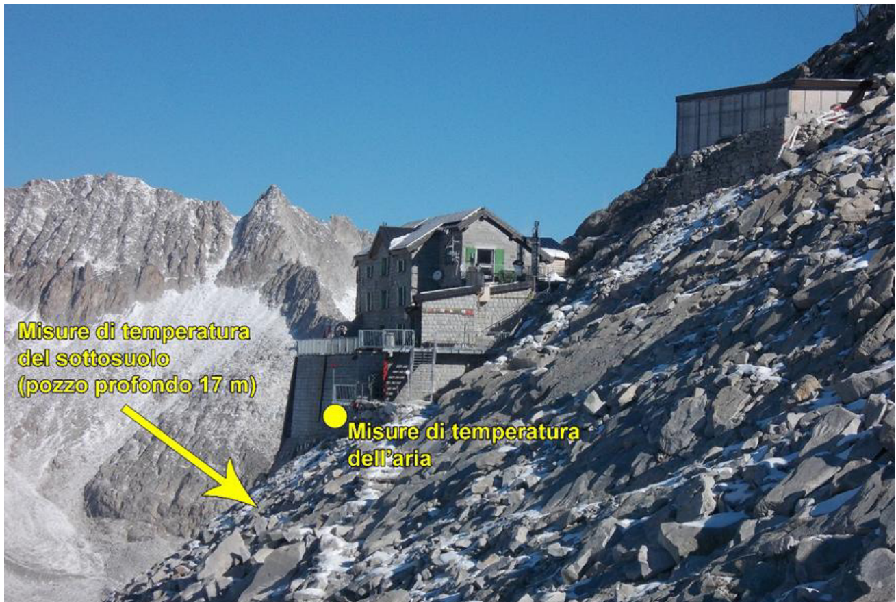
Fig. 18 – Il rifugio Ai Caduti dell'Adamello, con i siti di ubicazione della perforazione e della misura della temperatura dell'aria.
