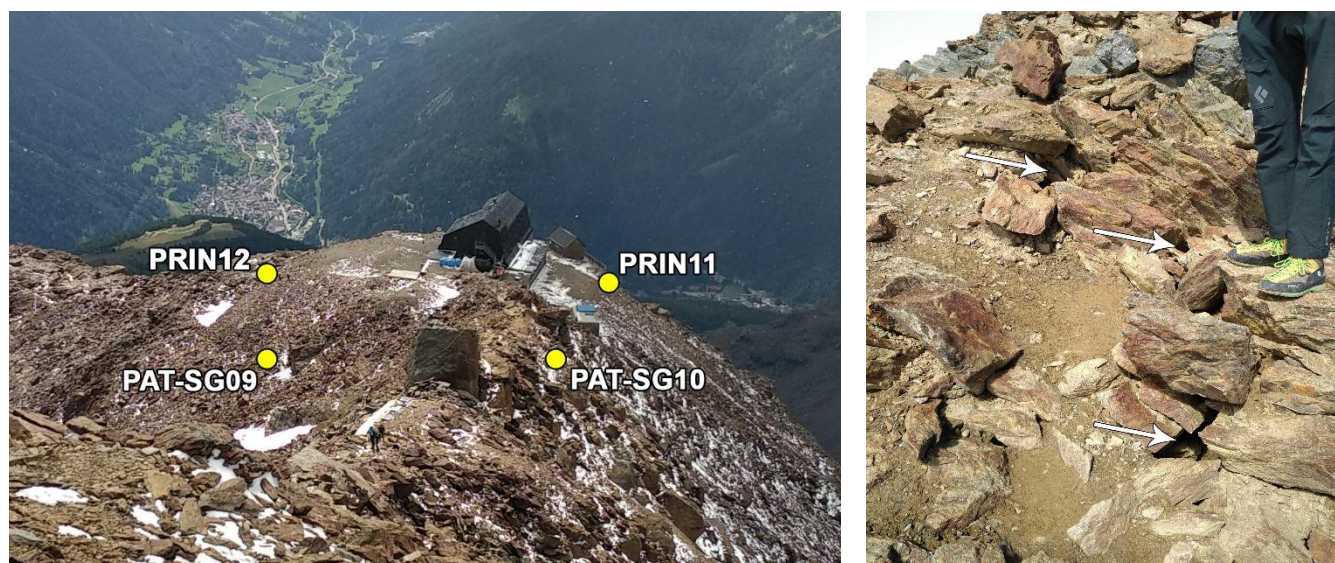
Fig. 24 – A sinistra, i siti GST situati presso il rifugio Mantova al Vioz; a destra, alcune fessure beanti osservate sulla cresta del Monte Vioz nell'estate del 2022.
