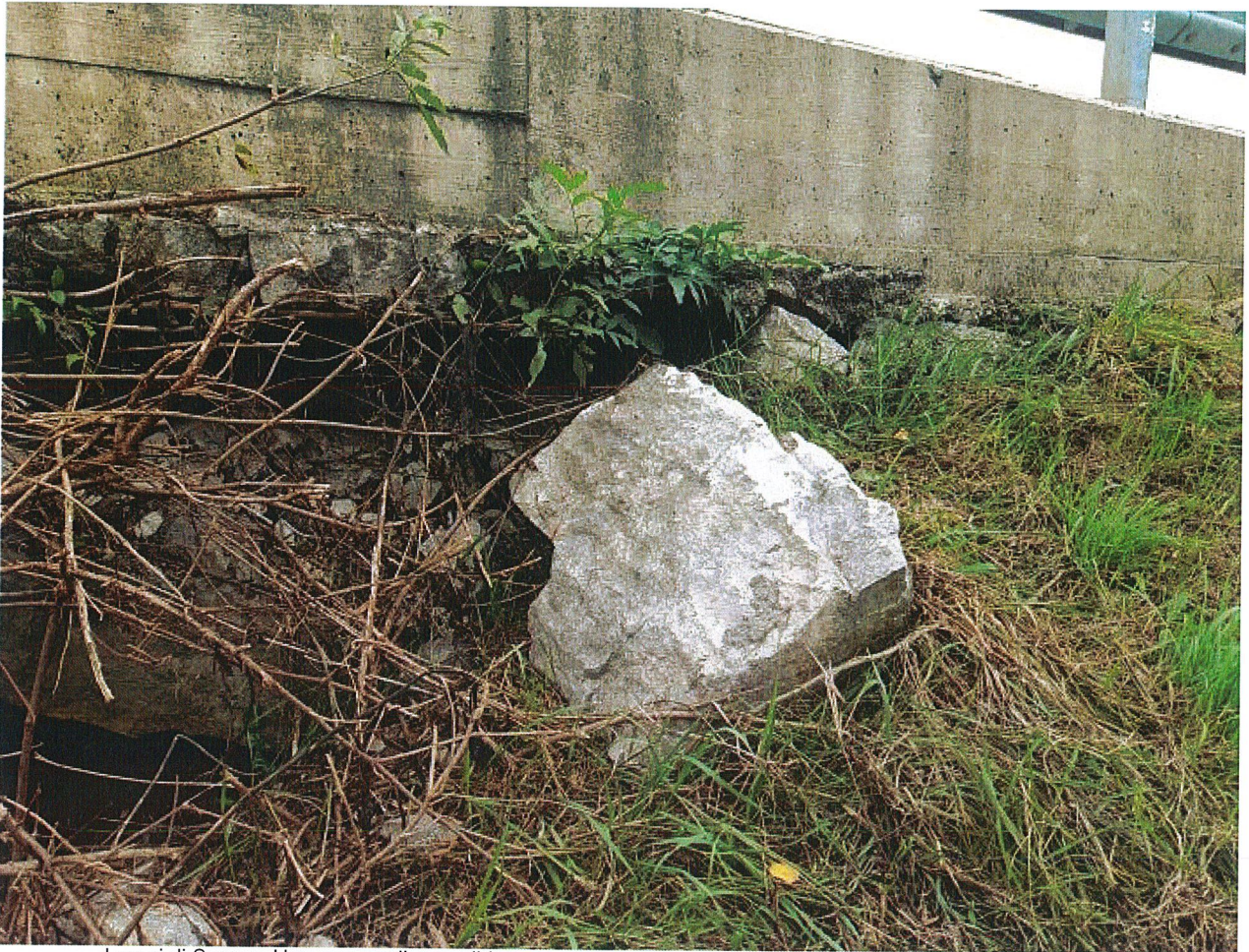
Lavori di Somma Urgenza per il consolidamento della sede stradale della S.S. 42 del Tonale e della Mendola in prossimità della pr. Km 194+370 circa , nel Comune di Novella.
